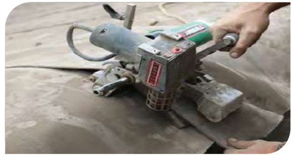
Figura 20 – Termo fusión entre mantas.
