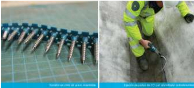
Figura 15 – Tornillos de acero inoxidable y su instalación.
