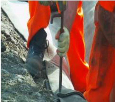
terreno (estacas) – Barras de acero para construcción.
