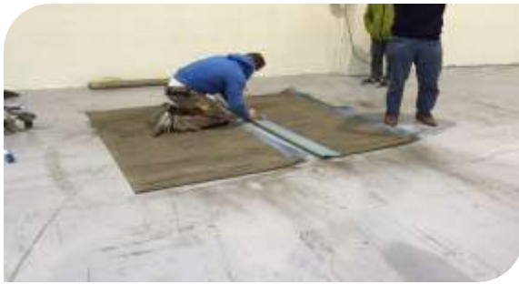
Figura 19 – Limpieza de zona de fusión.
