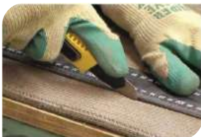
Figura 10 – Ejemplo de corte de manta de hormigón sin fraguar mediante “cúter”
