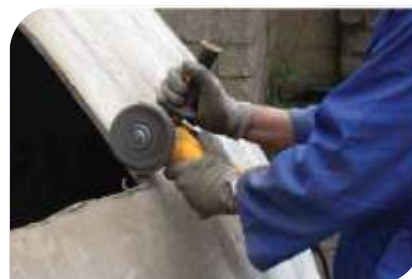
Figura 11 – Corte de manta de hormigón fraguada mediante sierras radiales.
