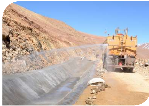
Figura 23 –Hidratación con maquinaria.
